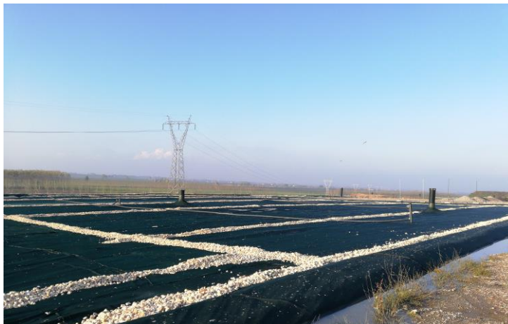
Figura 3: Telo in LDPE provvisorio (13/11/2019)
