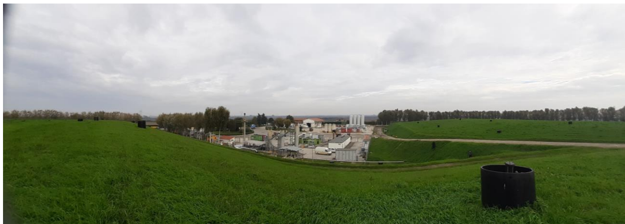
Figura 5: Manto erboso sul lato sud impianto e Area servizi (18/10/2019)
